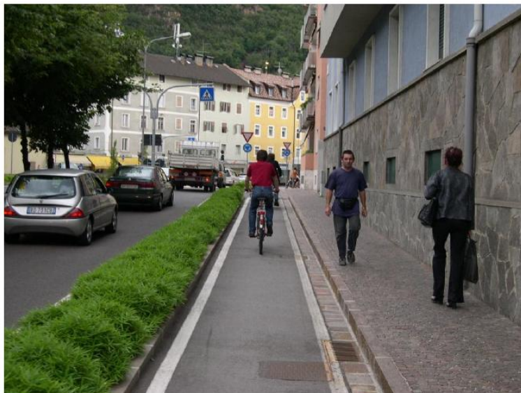
Monodirezionale a quota strada in sede propria
